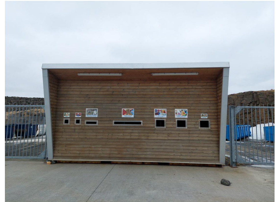
Mynd 8: Flokkunarstöð í Grímsey. Mynd LH
