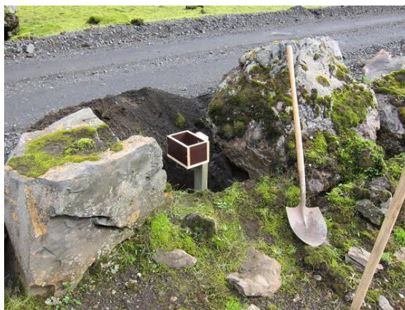
2. mynd. Bifreiðateljara komið fyrir í vegkanti.
