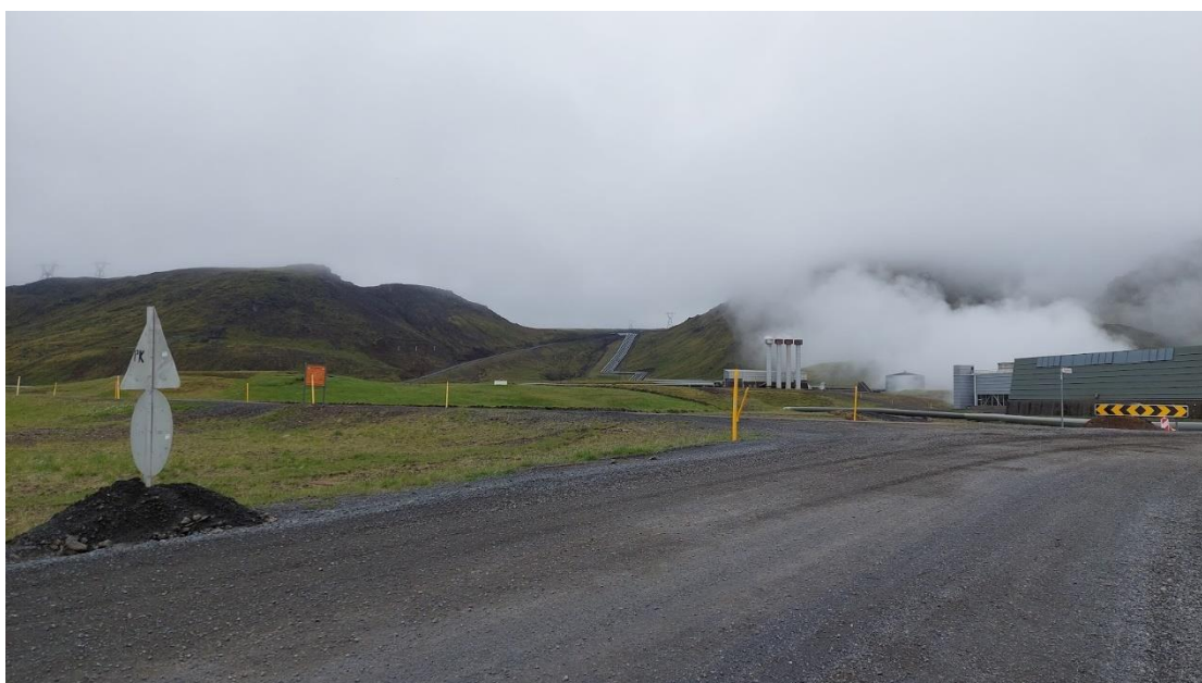
Mynd 21 Ásýnd á hluta Hellisheiðarvirkjunar og tengd mannvirki (mynd: Hjalti Jóhannesson).
