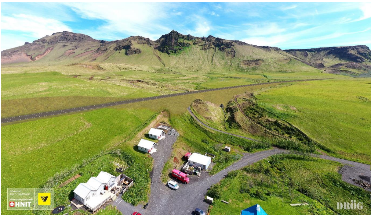
Horft yfir fristundabyggð í Norður-Vík og nýr vegur norðan við byggðina
