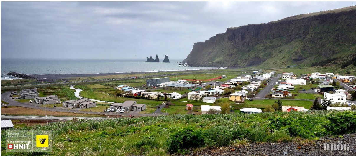
Mynd 6: Vegur um Víkurfjöru og vegskáli í Reynisfjalli.
