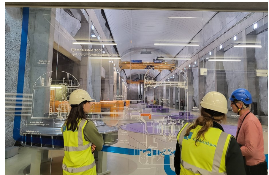
Mynd 3 Horft inn í vélasal Fljótisdalsstöðvar í Valbjófsstaðarfjalli. Mynd: EJB
